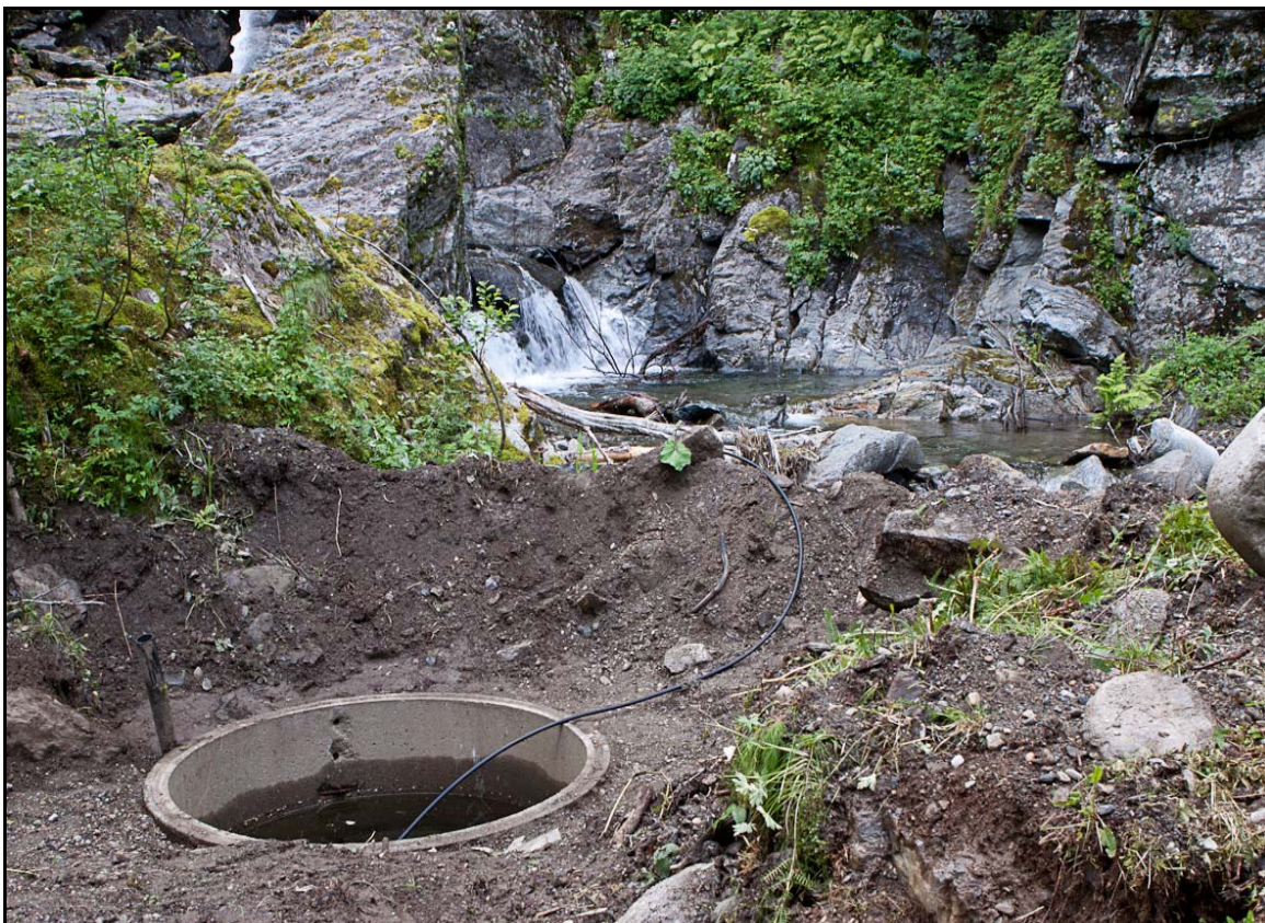
Figur 6. Inngrep ved elven. Høyst sannsynlig et drikkevannsuttak. Foto: Bjarne Oddane
